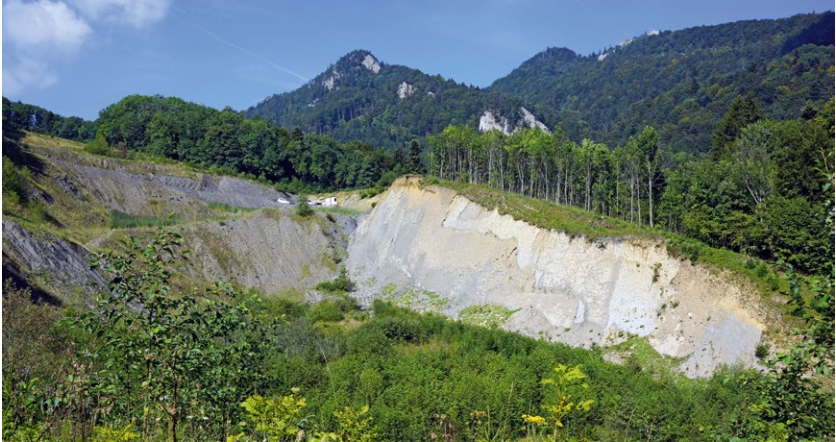
Fig. 35: Die stillgelegte Tongrube Fasiswald mit ihrer bekannten «Liaswand» vor der Auffüllung mit Ausbruchmaterial aus der dritten Röhre des Belchentunnels. Koord. 2629.180/1245.110, Blick in Richtung WNW. Foto P.F. Flückiger (Naturmuseum Olten), 2013.
